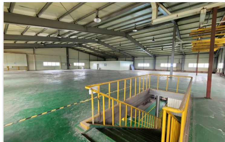
공장(나동) 내부 2층
